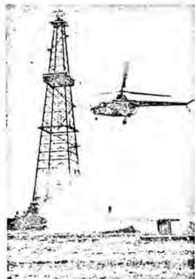
Скважина на месторождении Шатлык.
